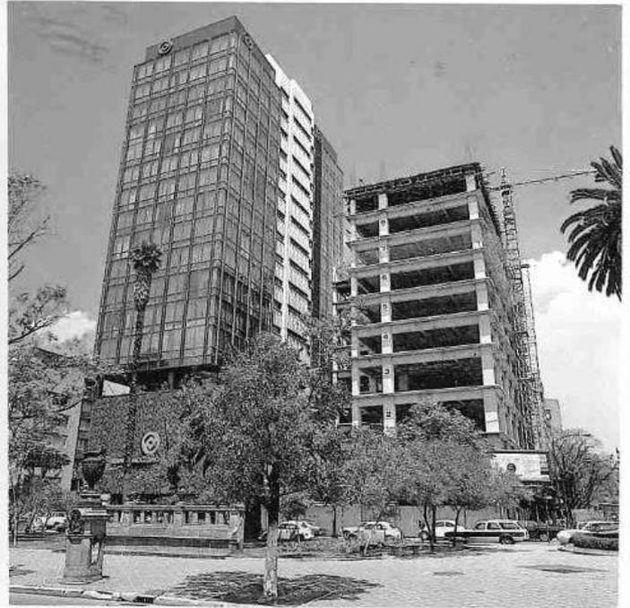
ciudades del mundo. Toda la construcción será de concreto armado utilizándose entre cimentación y estructura 8,500 m<sup>3</sup> de concreto. En la parte superior se construirá un heliopuerto. La fachada llevará aluminio anodizado color bronce, al igual que los cristales que dan hacia la calle, dando en conjunto la impresión de una gran pieza metálica.
